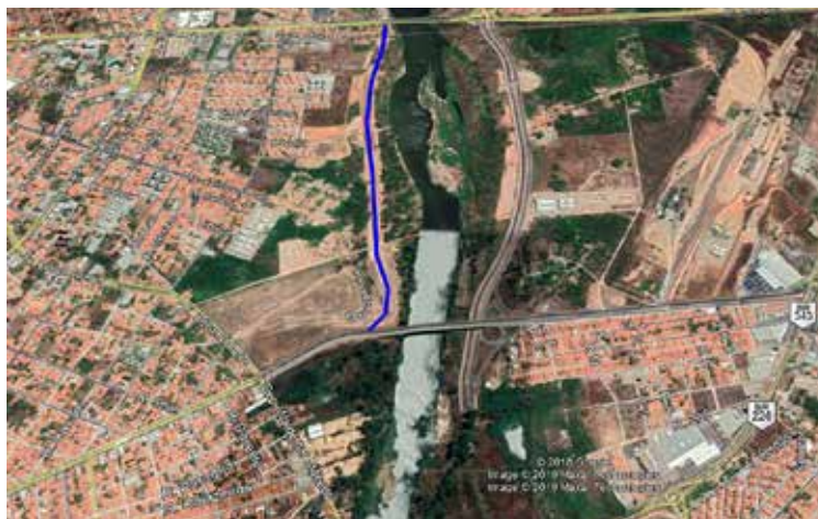
Figura: Trecho em construção da 2ª etapa da Avenida Marginal Sul Fonte: Google Earth. Data da imagem: 09/09/2019.
