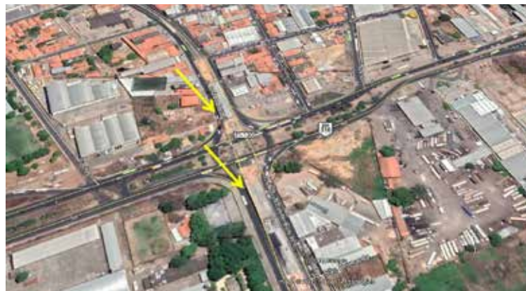
Construção do viaduto da Avenida Barão de Gurgueia Fonte: Google Earth. Data da imagem: 09/09/2019.
