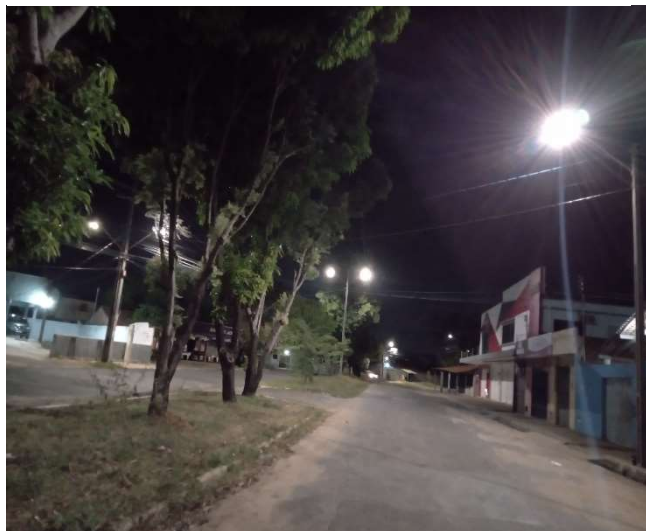
Imagem 53 - Rede de IP avenida Prefeito Freitas Neto
