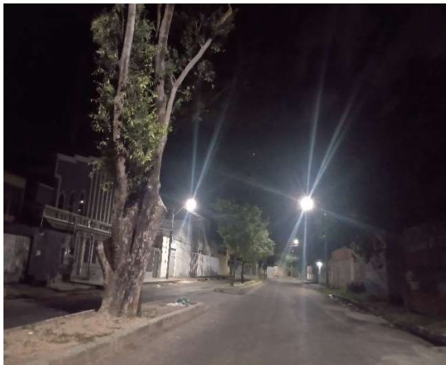
Imagem 52 - Rede IP avenida Cleanto Jales de Carvalho
