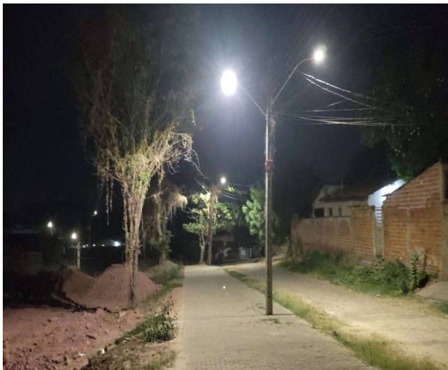
Imagem 44 - Iluminação Calçada e quadra de areia da R. Apolo XI
