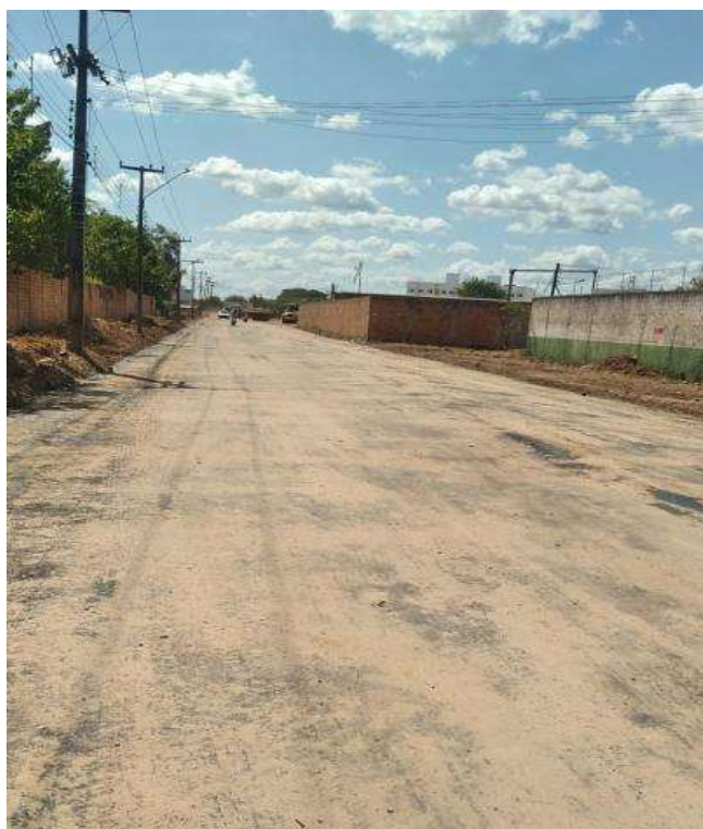
Imagem 1 e 2 – Recuperação asfáltica Av. Poty Velho
