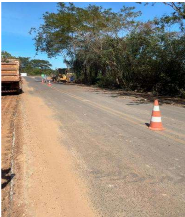
Imagem 3 e 4 – Recapeamento Asfáltico Av. Professor Camilo Filho
