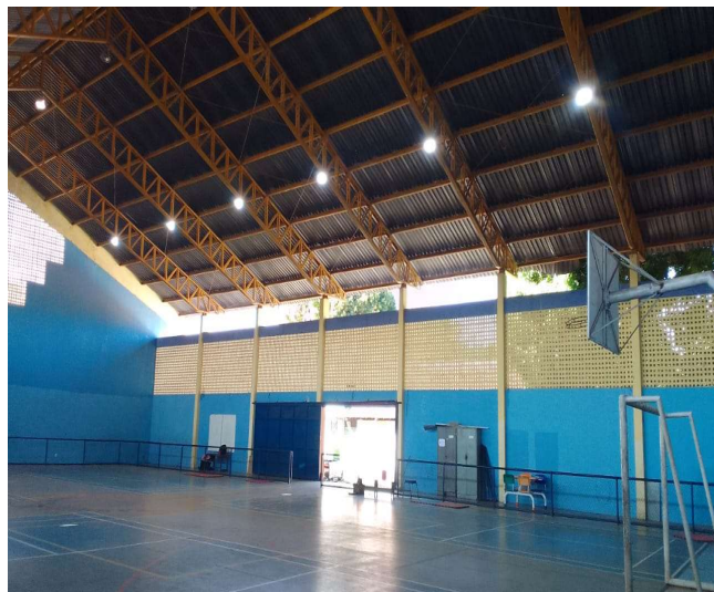
Imagem 49 - Quadra de esportes Escolão Itararé
