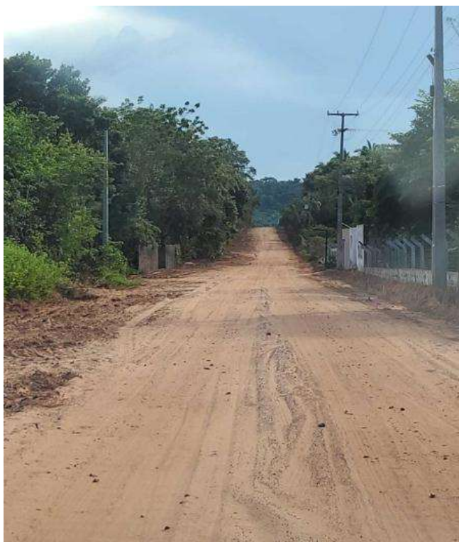
Imagem 5 e 6 – Pavimentação Estrada do Boqueirão
