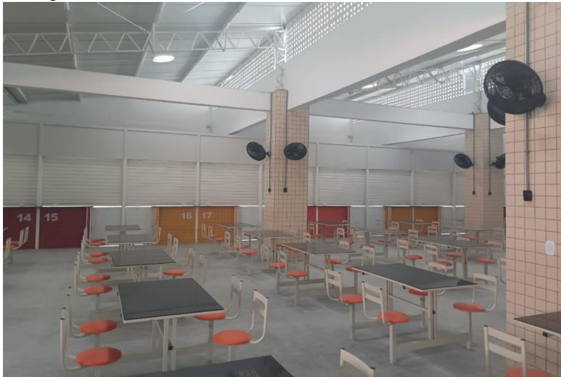
Figura 4 - Reforma do setor de restaurante do Mercado São José
