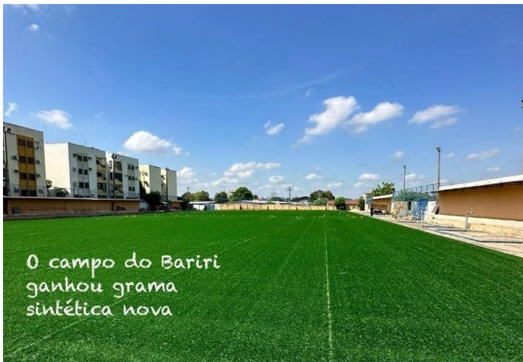
Figura 8 - Construção do campo do Bariri
