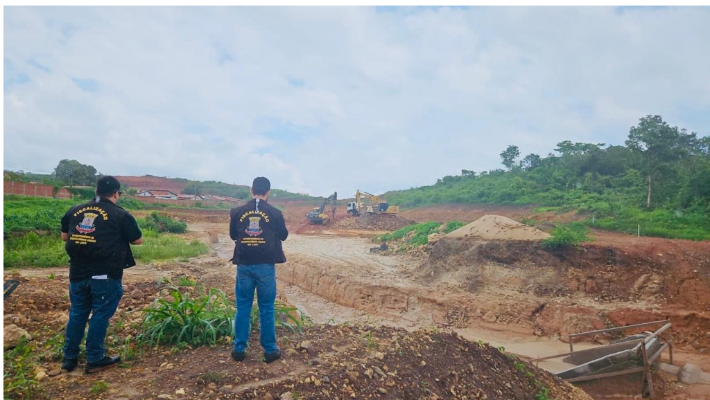
Figura 8 - Fiscalização de Obra de Drenagem na Zona Leste de Teresina
