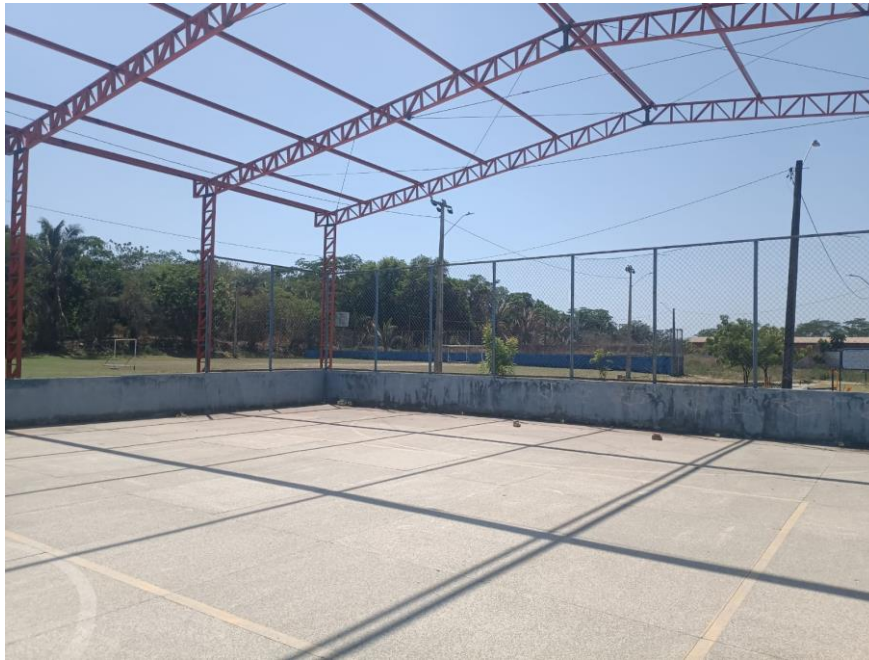
Figura 11 - Cobertura de Quadra Poliesportiva no Bairro Pedra Mole
