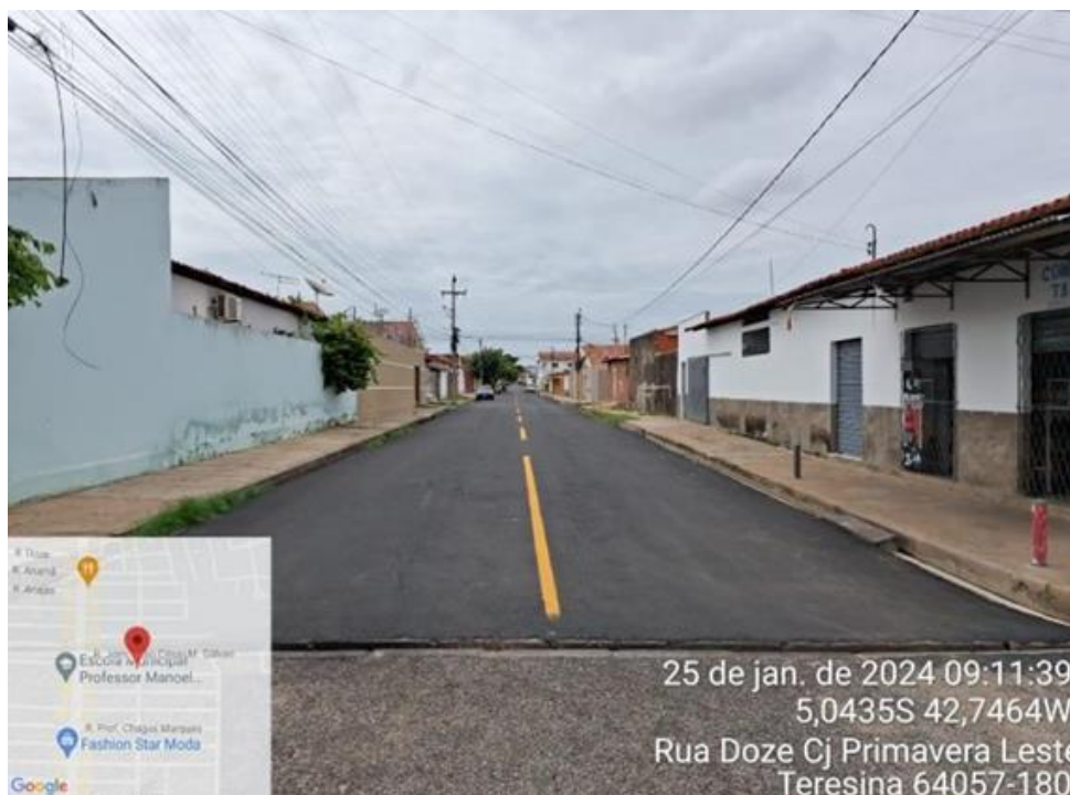
Figura 9 - Pavimentação Asfáltica na Zona Leste de Teresina
