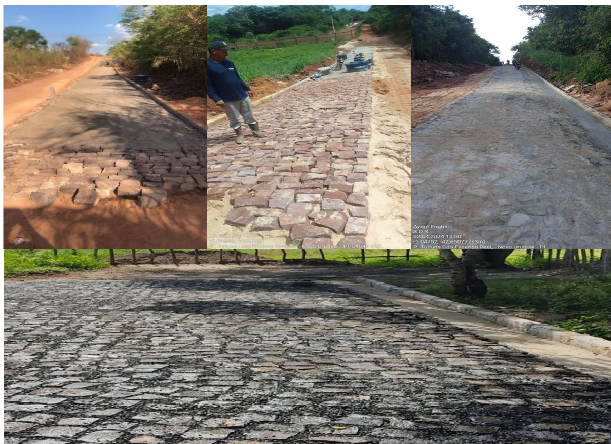
Figura 03 – Implantação e Recuperação de Pavimentação em Paralelepípedo na Zona Rural.
