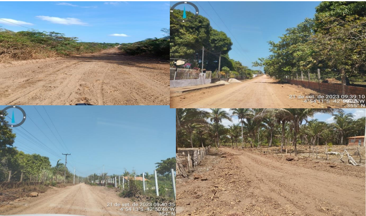
Figura 04 – Recuperação de Estradas Vicinais na Zona Rural
