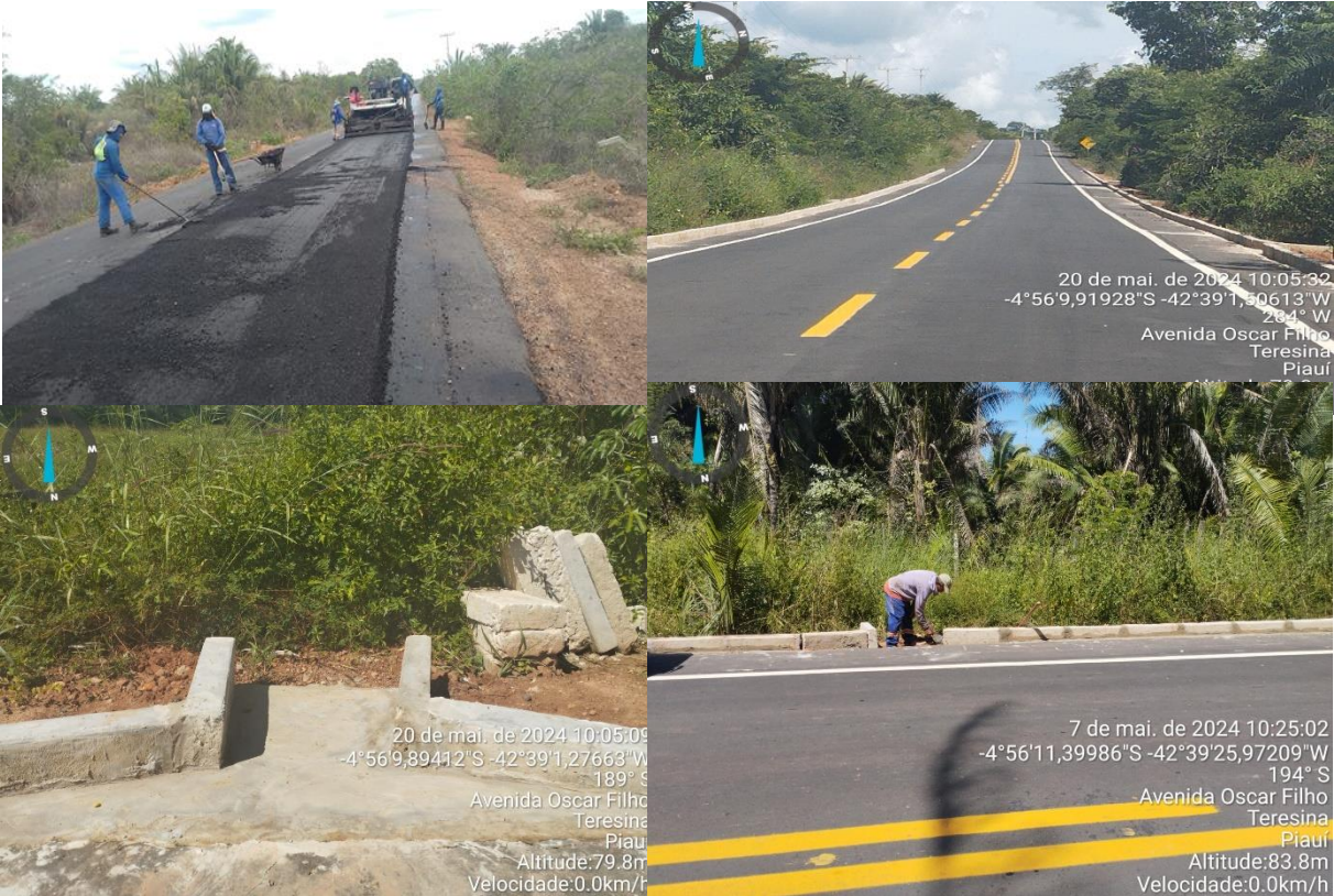
Figura 02 - Pavimentação Asfáltica na Localidade Fazenda Nova Leste/Amparo/Bulena.
