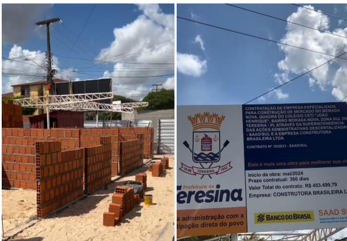
Figura 13 - Construção do Mercado do Morada Nova
