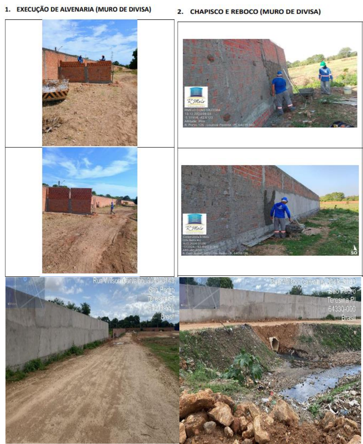
Figura 6- Construção da Galeria do Bairro São Pedro
