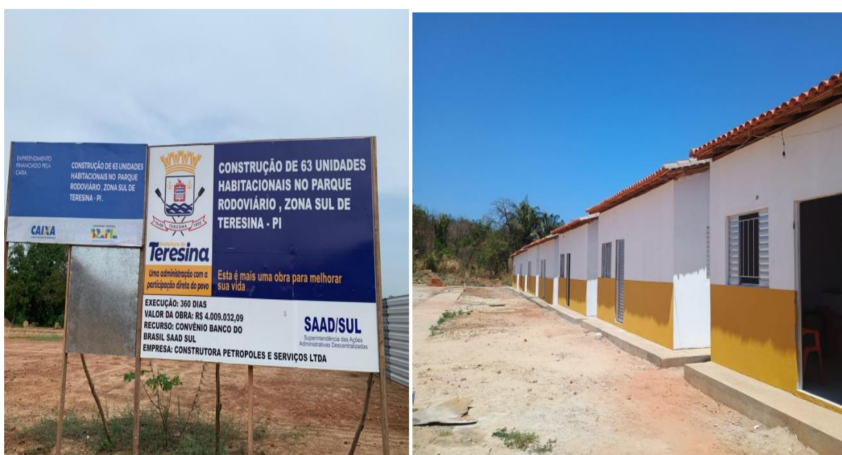
Figura 4 - Construção de Casas no Parque Rodoviário
