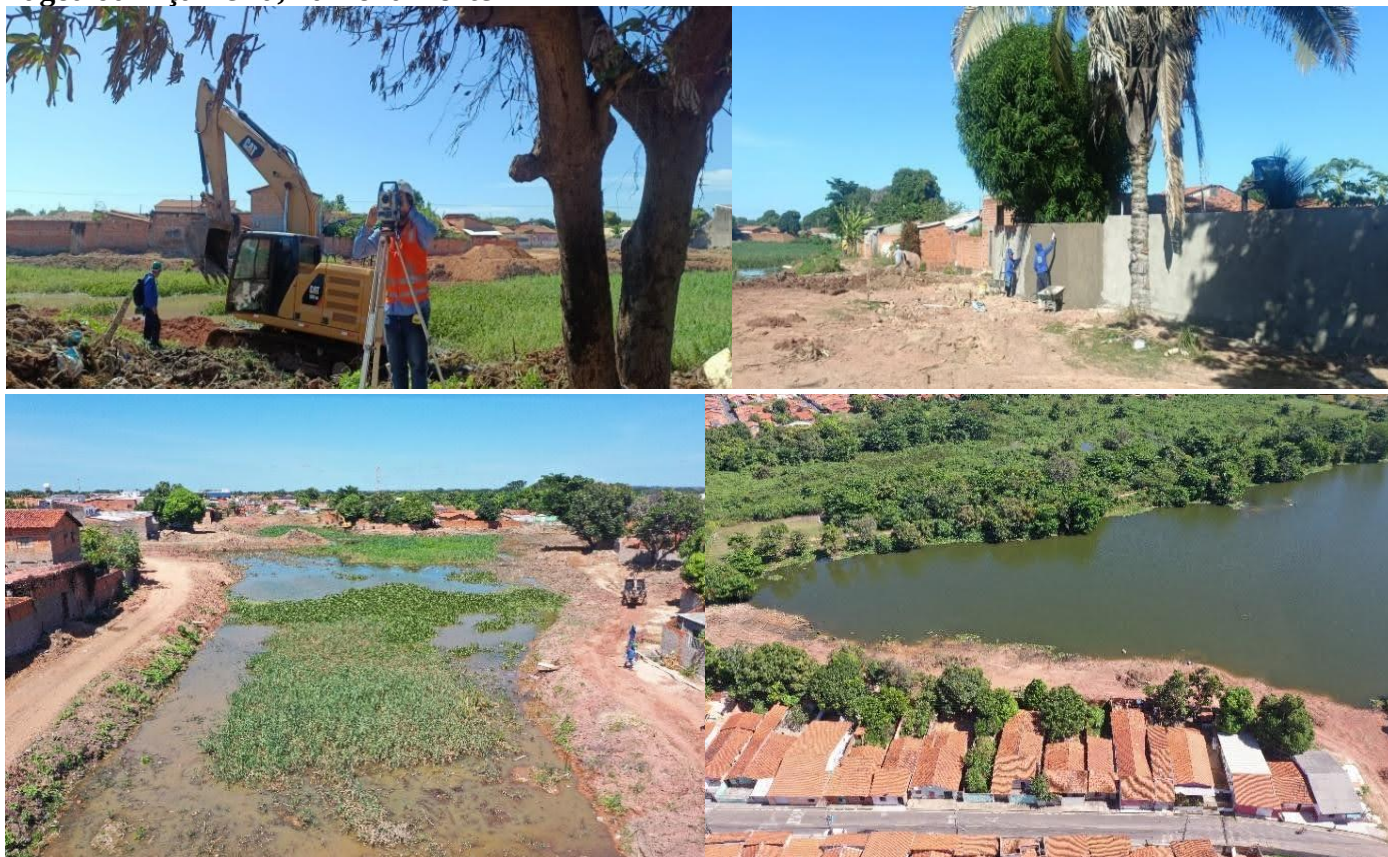
Figura 69 - Execução das Obras de Drenagem e Urbanização da Lagoa do São Joaquim e Etapa da Lagoa da Piçarreira, na Zona Norte
