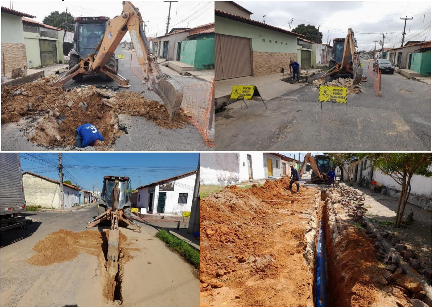
Figura 73 - Execução das Obras de Construção de Galerias e Sistema Elevatório para Águas Pluviais no Bairro Parque Alvorada
