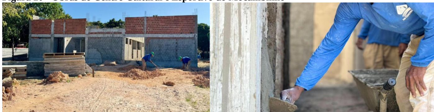
Figura 20 - Obras do Centro Cultural e Esportivo do Mocambinho
