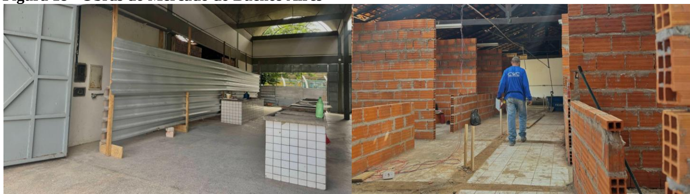
Figura 18 - Obras do Mercado do Buenos Aires
