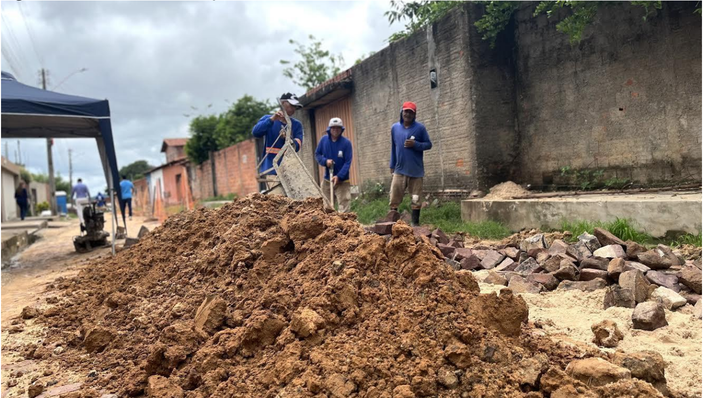
Figura 14 - Obra de Revitalização de Canaleta
