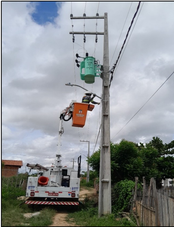
Imagens 41 e 42: Instalação de luminárias do Vila Magnólia.
