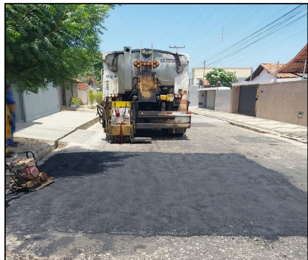
Imagens 5 e 6: Execução de serviços de manutenção e recomposição asfáltica em via urbana.
