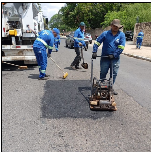
Imagens 5 e 6: Execução de serviços de manutenção e recomposição asfáltica em via urbana.
