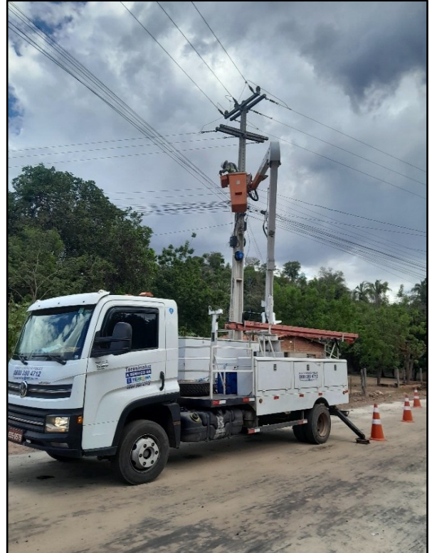
Imagens 43 e 44: Instalação de luminárias no povoado Baixão do Carlos.
