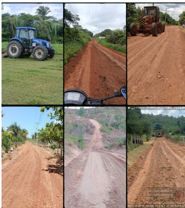
Figura 02 – Recuperação de Estradas Vicinais na Zona Rural
