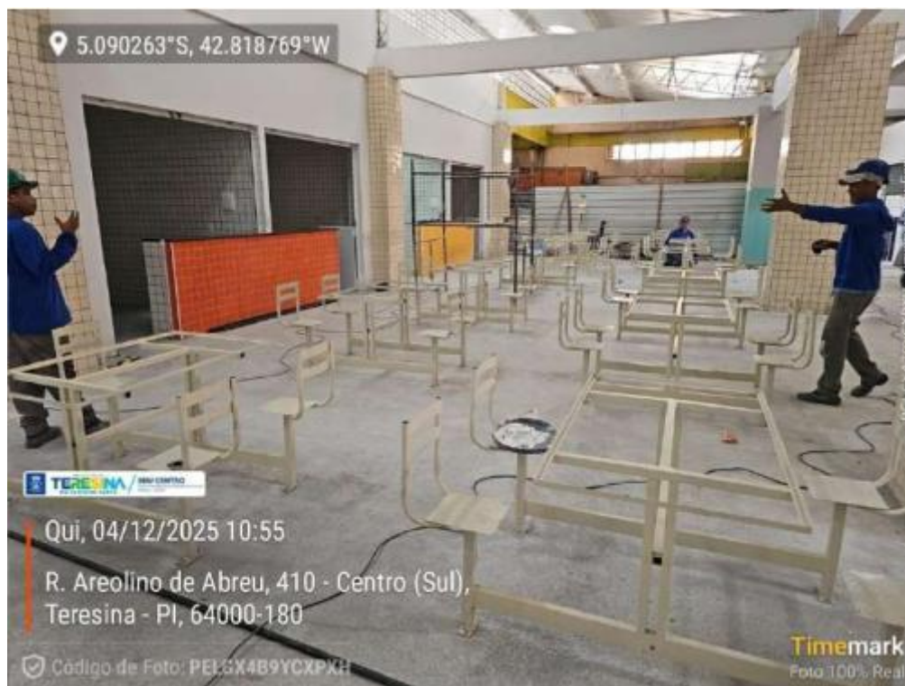
Figura 11: Obras de infraestrutura do Mercado Central
