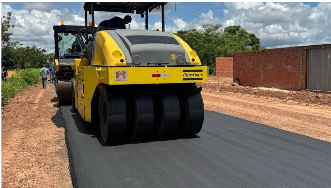
Figura 26 - Pavimentação Asfáltica na Av. Themístocles Sampaio
