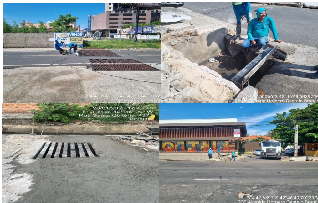
Figura 23 - Recuperação de Galerias na Zona Leste da Capital
