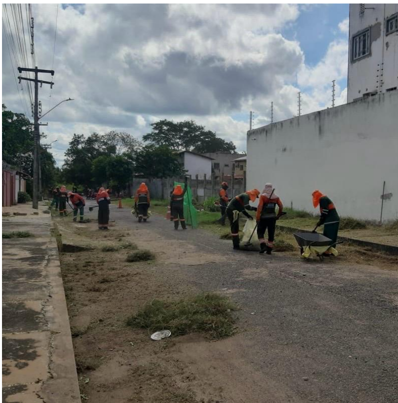
Figura 16 - Limpeza e Capina de Ruas no Bairro Ininga
