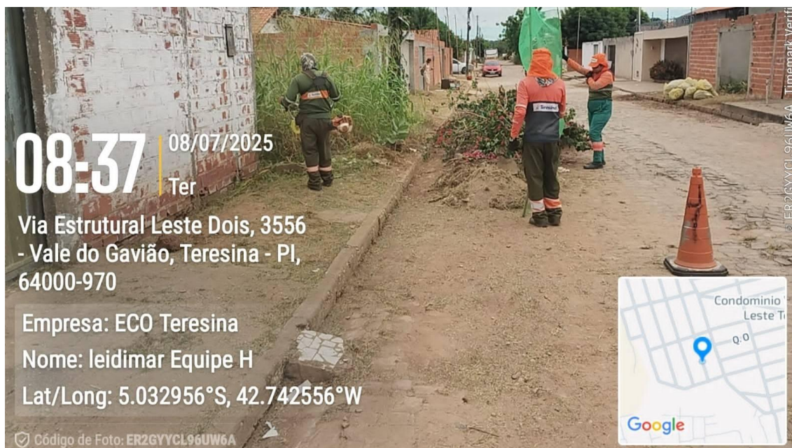
Figura 18 - Limpeza em Ruas no Bairro Vale do Gavião
