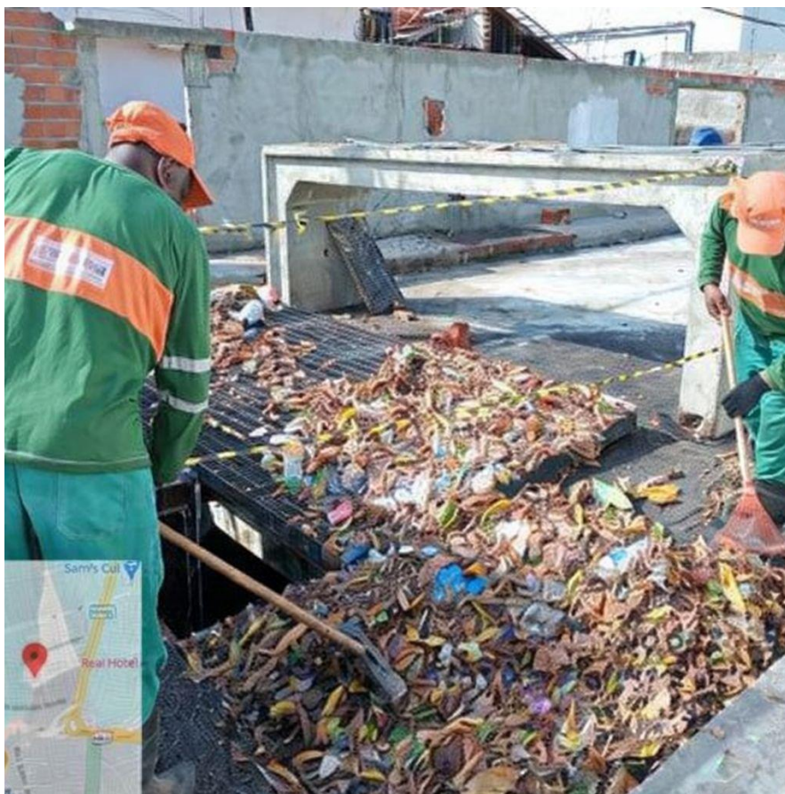
Figura 17 - Serviços de Limpeza em Bueiros no Bairro São Cristóvão
