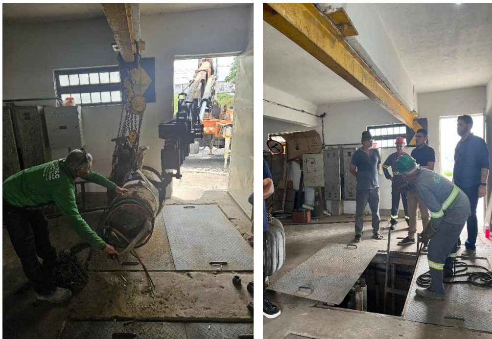
Figura 35 - Correção e Recuperação da Bomba Mandacará
