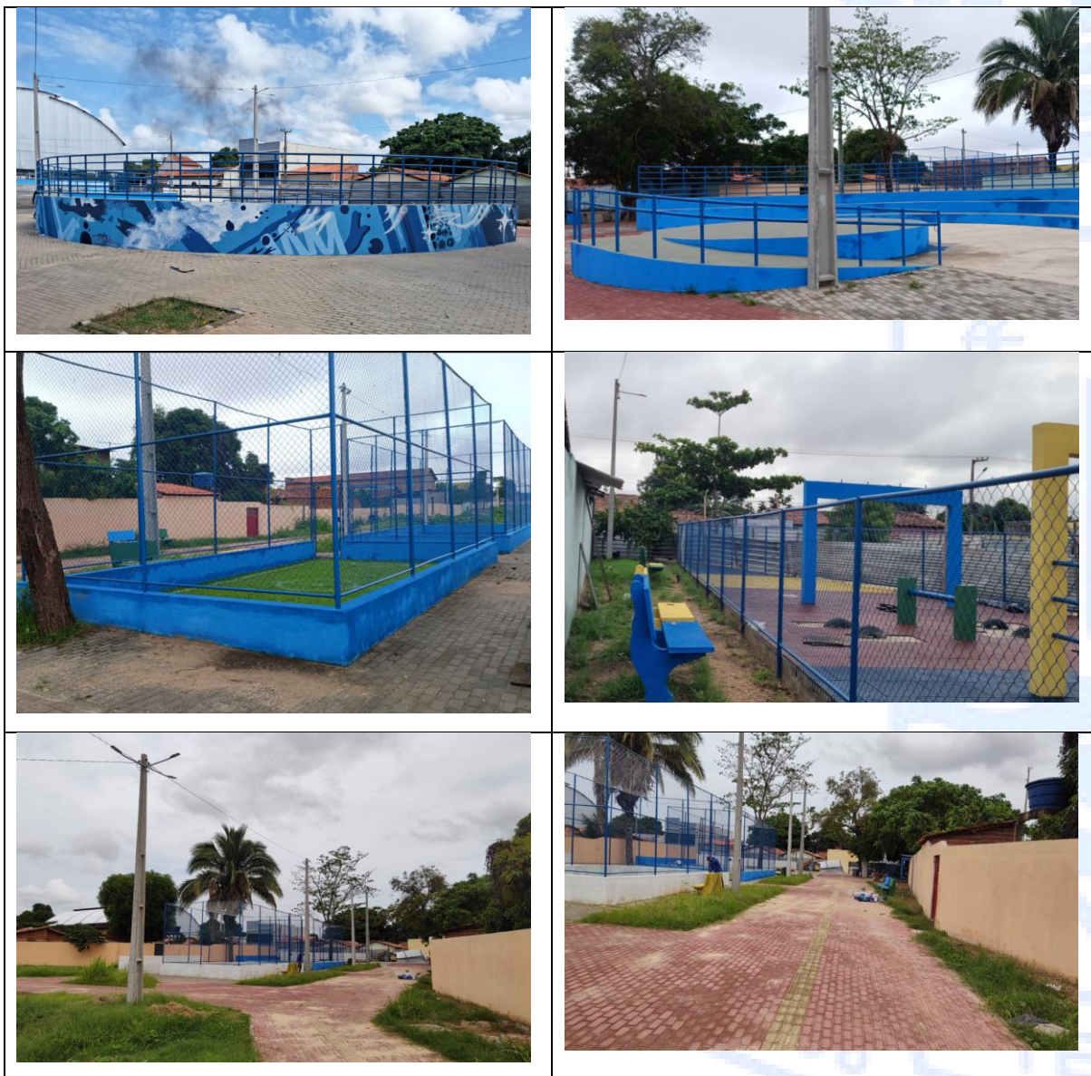
Figure 22 - Serviços Realizados na Drenagem e Urbanização da Lagoa do São Joaquim
