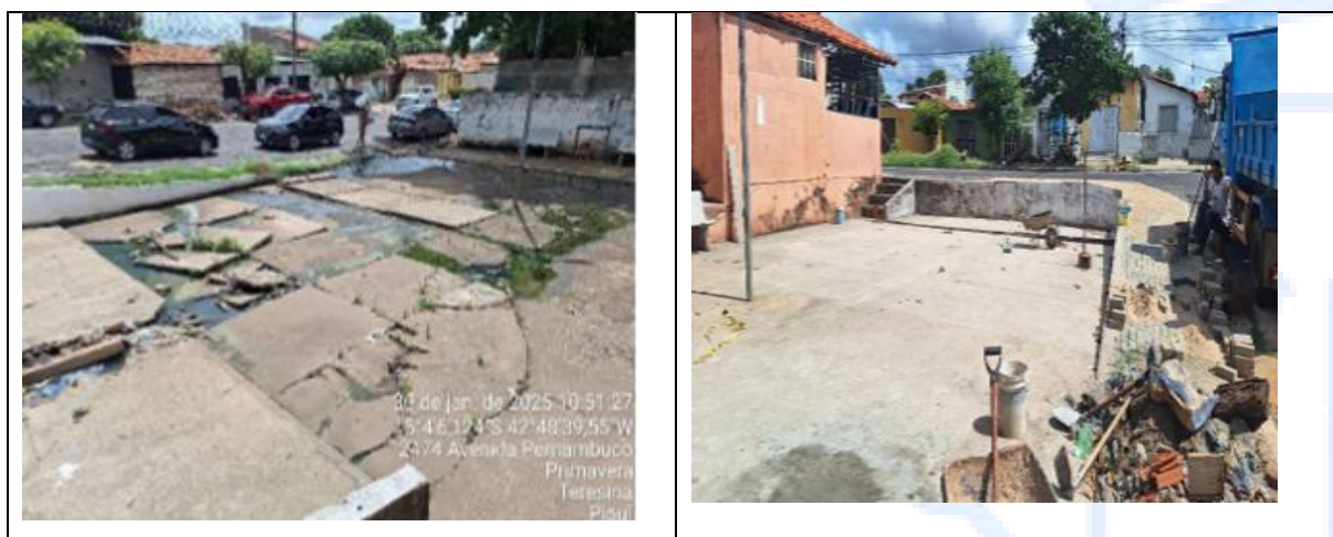
Figure 14 - Reforma Piso da Praça do Bairro Primavera
