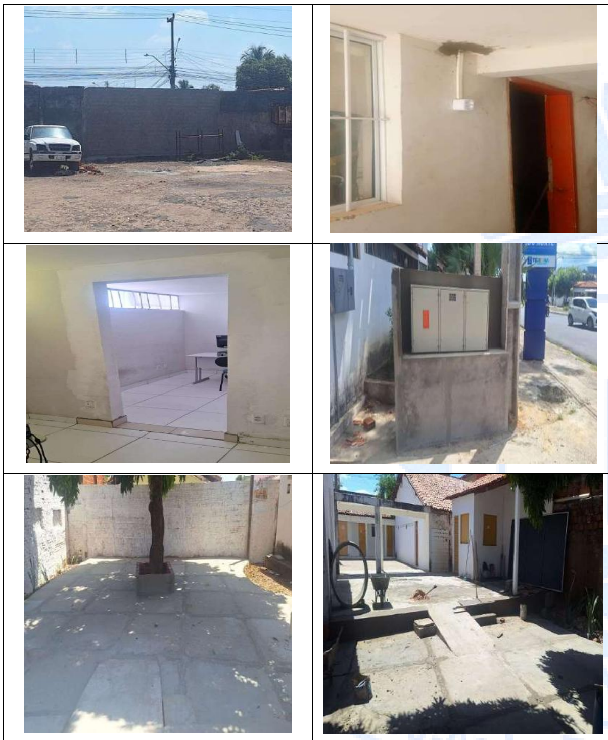
Figure 11 - Reforma Pontuais na Sede da SDU Norte
