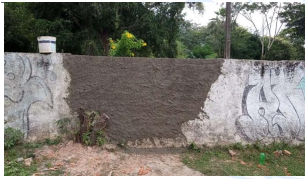
Figure 10 - Reforma no Muro do Cemitério do Buenos Aires
