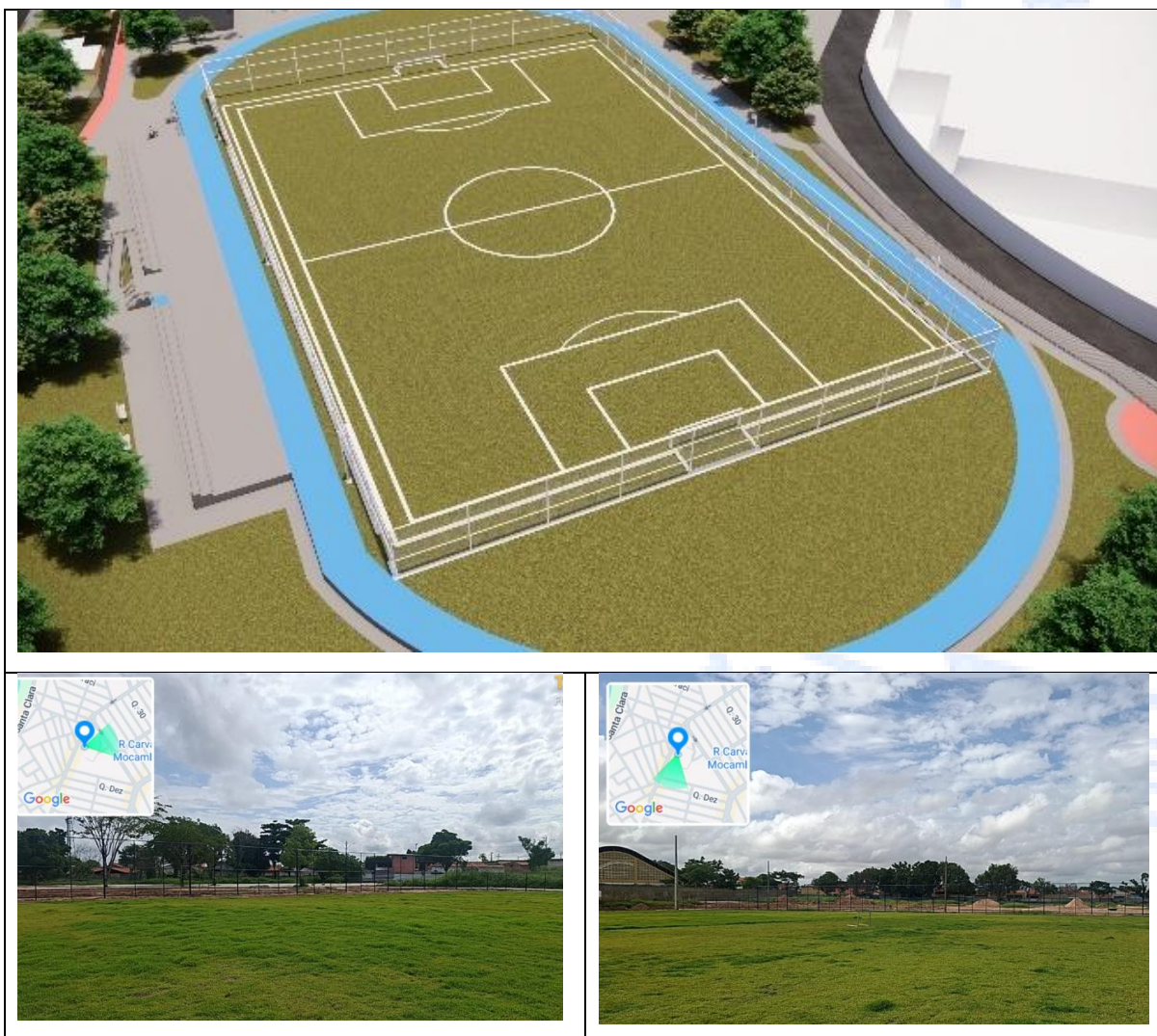
Figure 20 - Serviços Realizados na Revitalização do Centro Esportivo do Escolão do Mocambinho.
