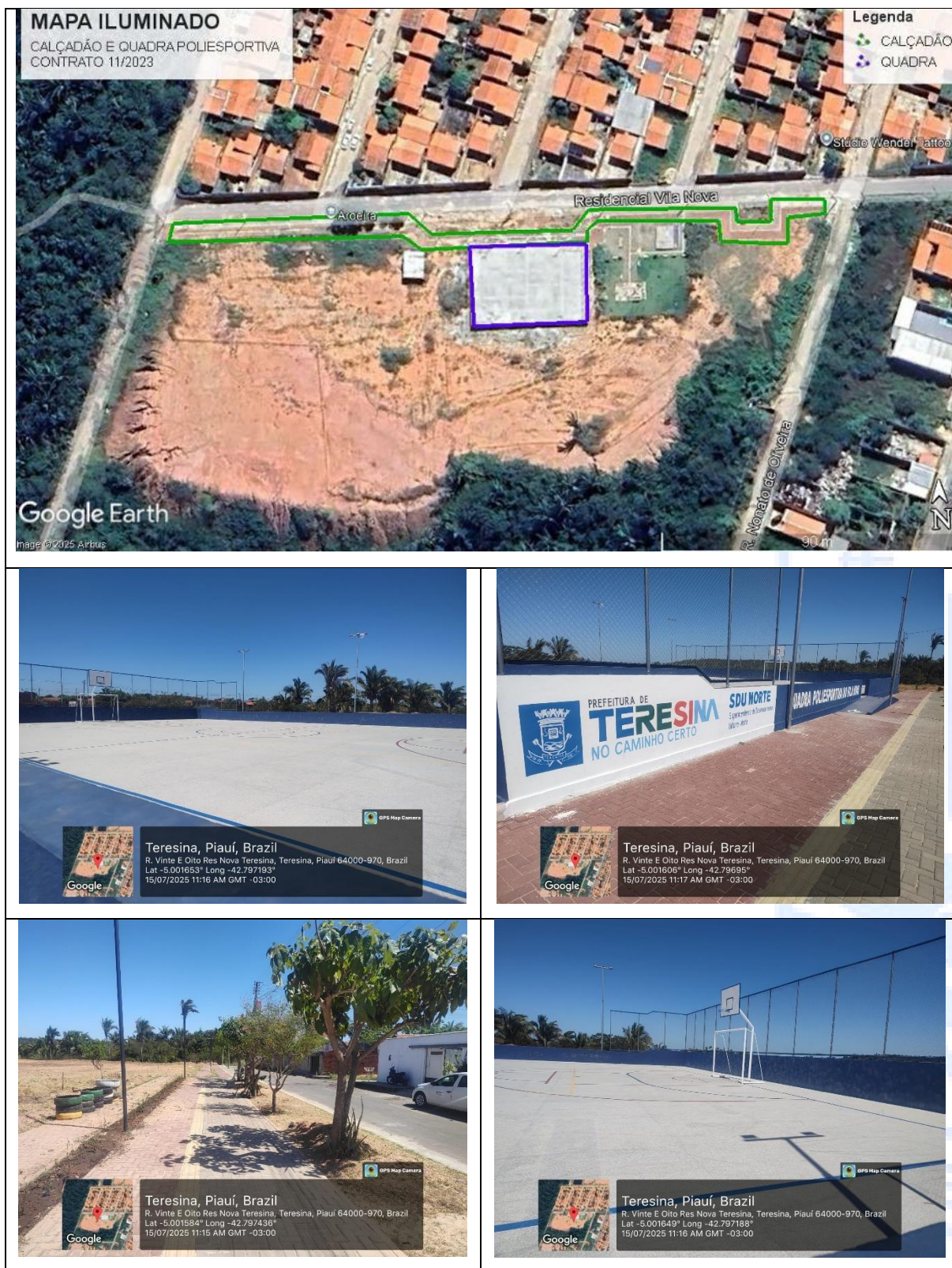
Figure 25 - Serviços Realizados na Quadra Poliesportiva da Rua Osmar Mendes, no Residencial Vila Nova
