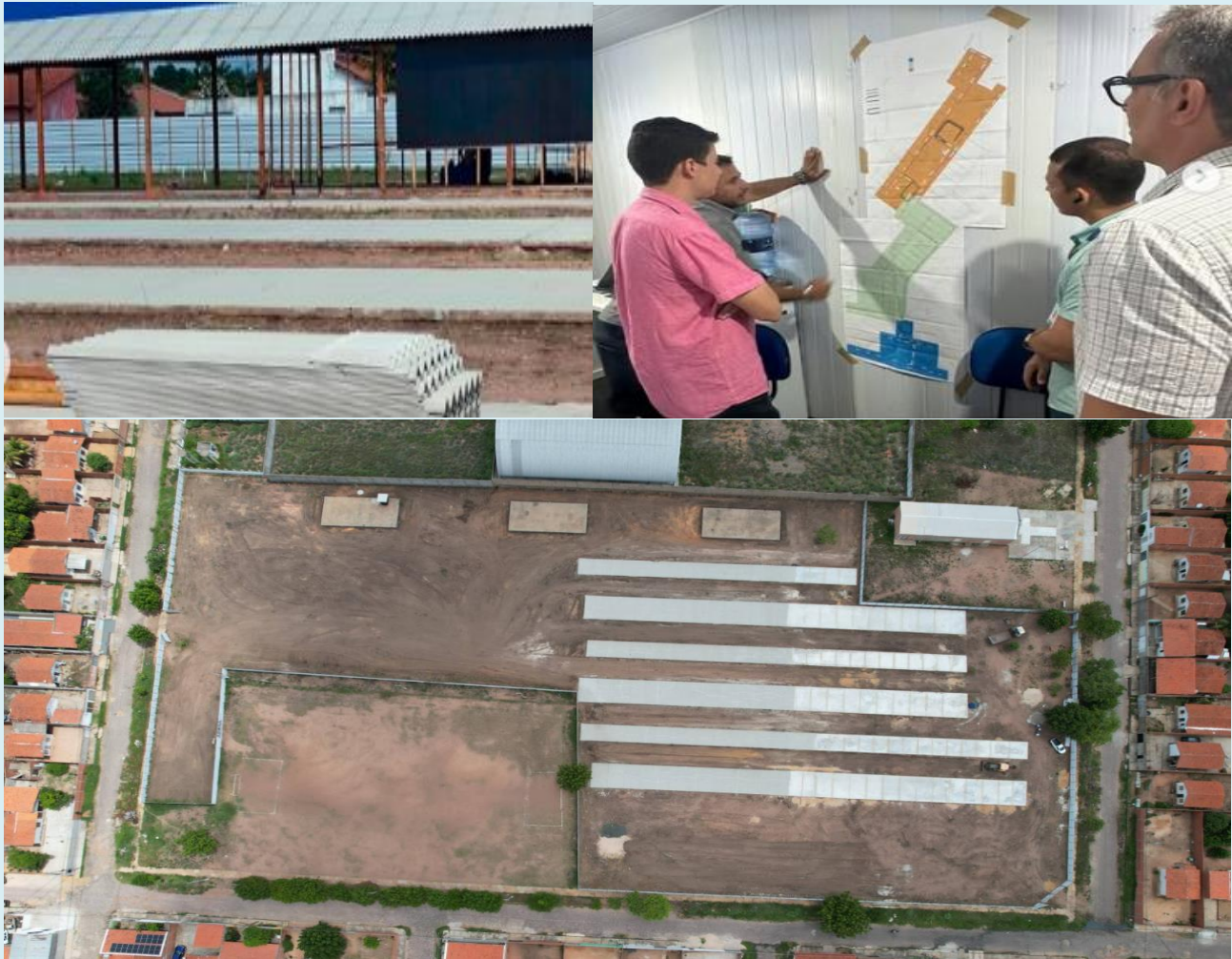
Figura 7- Início das obras da Galeria do Torquato Neto (PE-31)
