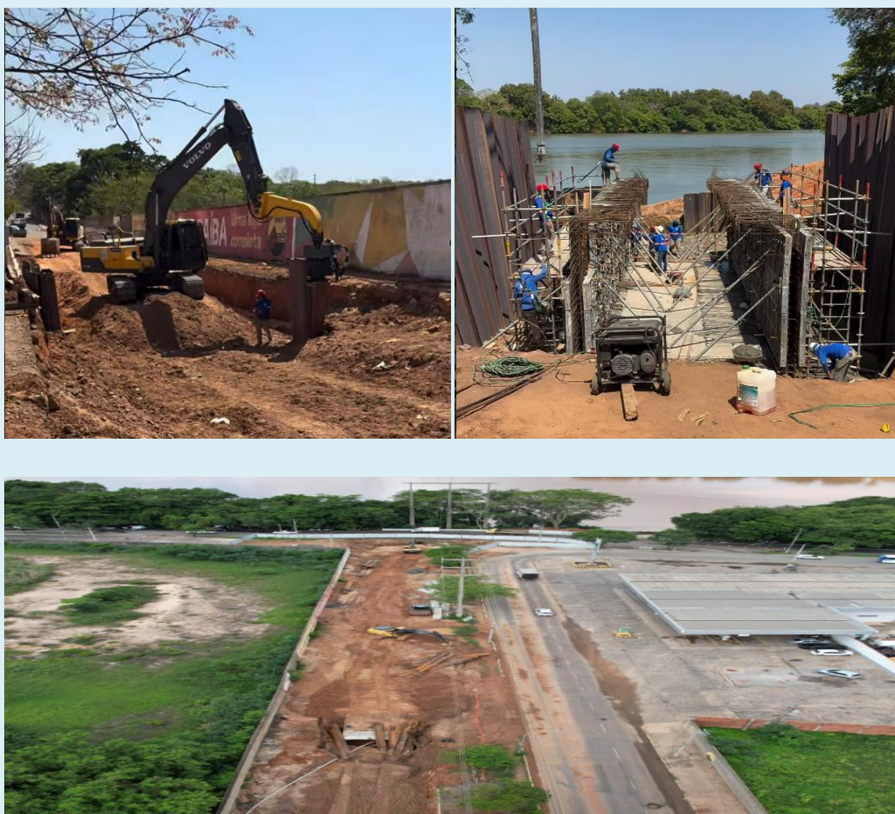
Figura 6- Construção da Galeria do Bairro São Pedro
