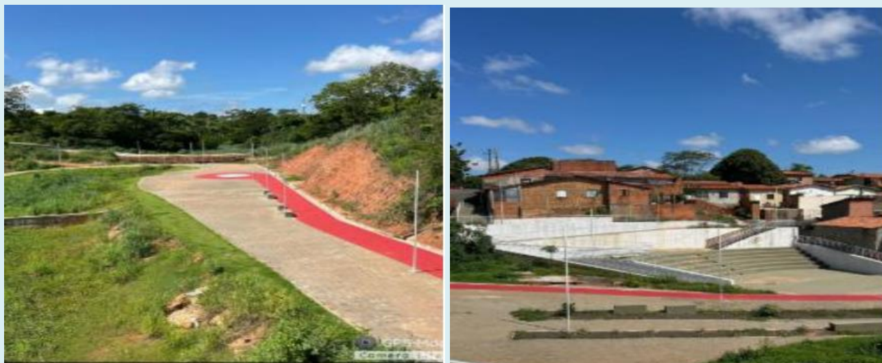
Figura 9- Urbanização no entorno do Parque Rodoviário
