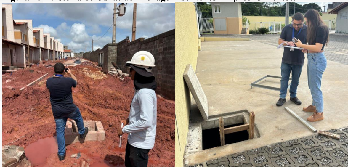
Figura 76 - Vistoria de Obras de Drenagem de Novos Empreendimentos.
