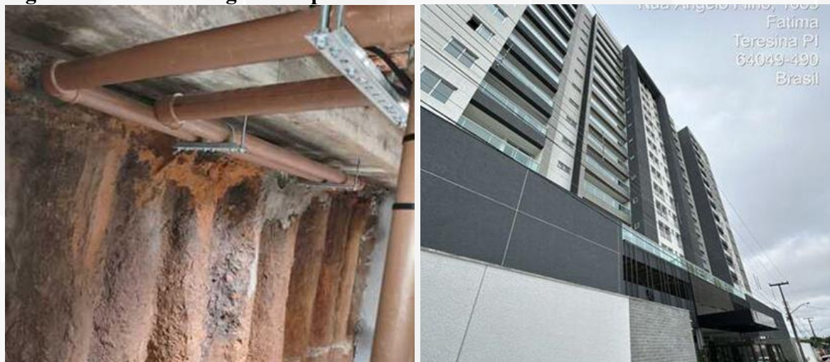
Figura 77 - Vista de Alguns Empreendimentos vistoriados.
