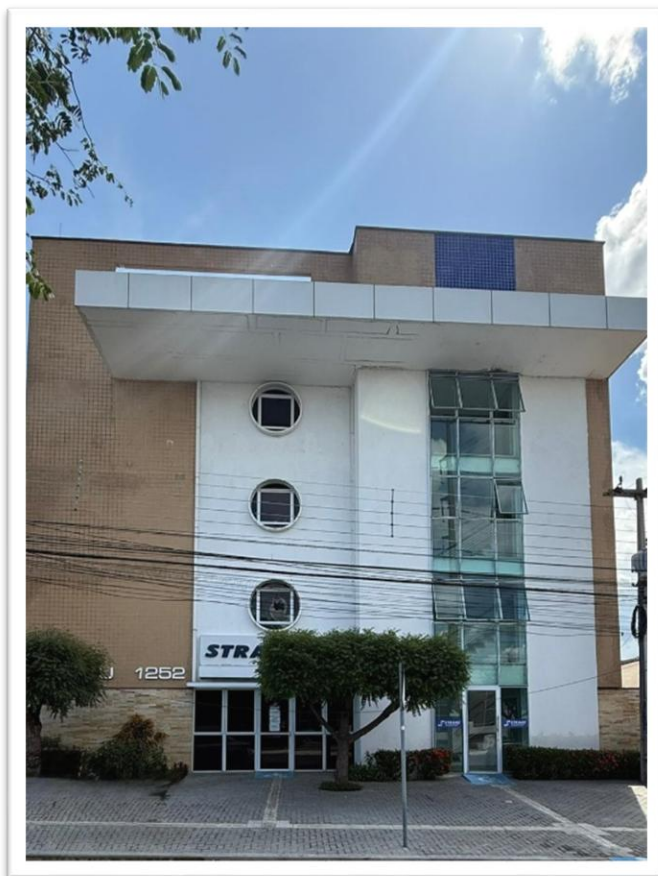
Figura 3: Prédio de Sede Administrativa da STRANS
