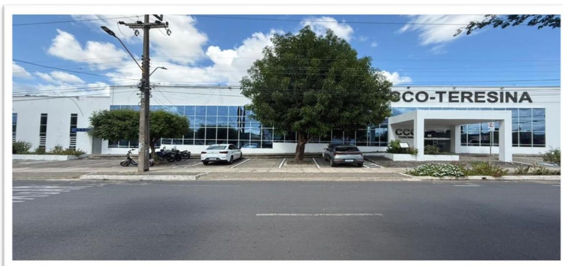
Figura 2: Prédio DOFT e CCO da STRANS
