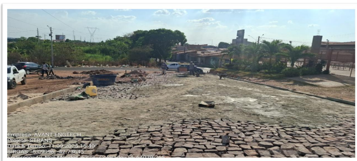
Figura 11: Obra de melhorias na Rua Pedro Teixeira (binário com Av. Noé Mendes)
